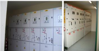
Mittelspannungsschaltanlage
