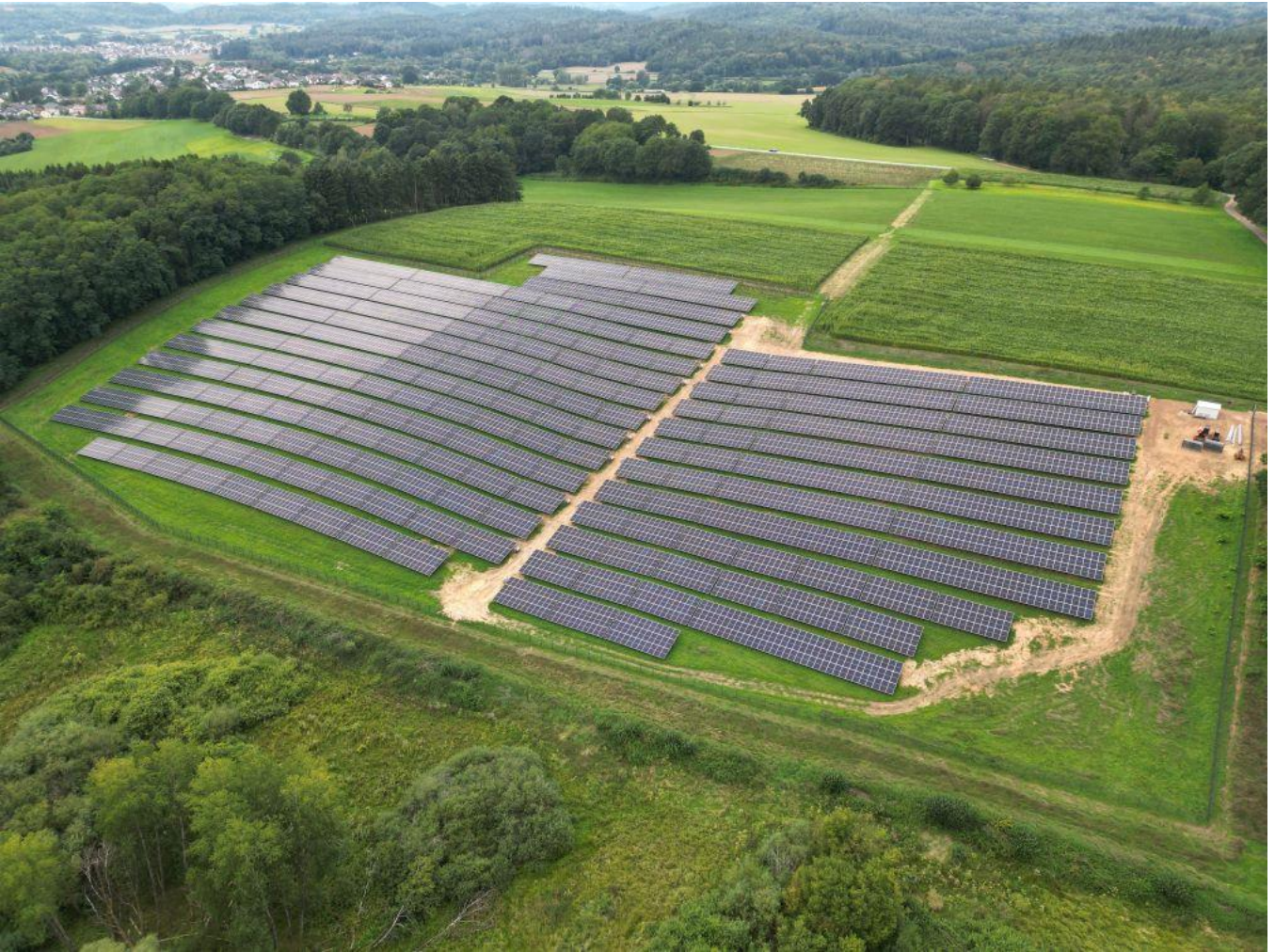
Der Solarpark Rimlingen.
