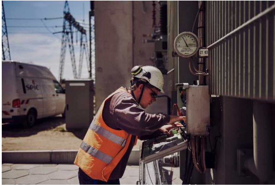
Arbeiten am Umspannwerk
