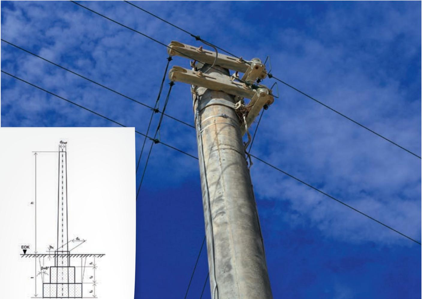
**Gründungen nehmen die auf den Mast wirkenden Kräfte auf und übertragen diese in den Baugrund. Art und Dimensionierung sind abhängig vom Baugrund, vom Mast und von den aufzunehmenden Belastungen. Bei der Wahl der Gründungsart können auch die am Standort gegebenen örtlichen und technischen Bedingungen relevant sein.**
